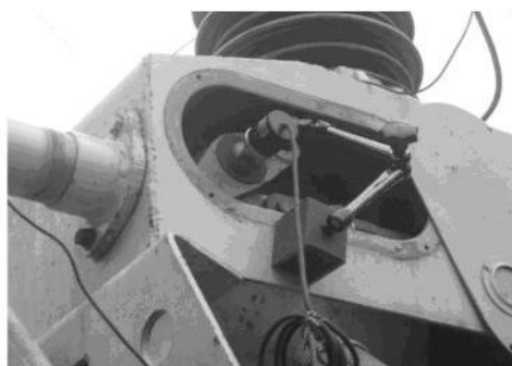
110KVSF6 开关传感器安装
