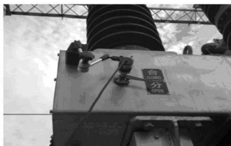
35KVSF6 开关传感器安装
