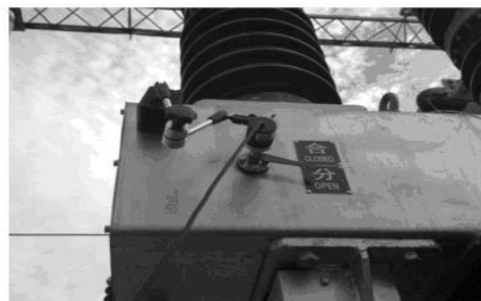
35KV SF6 开关传感器安装
