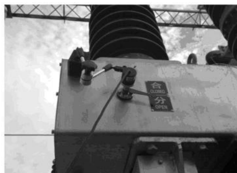
35KV SF6 开关传感器安装
